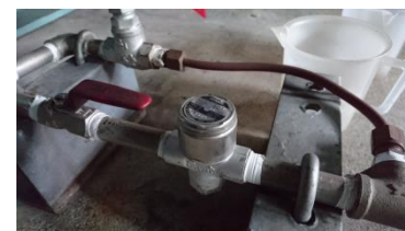
蒸気ドレン回収装置の改修
